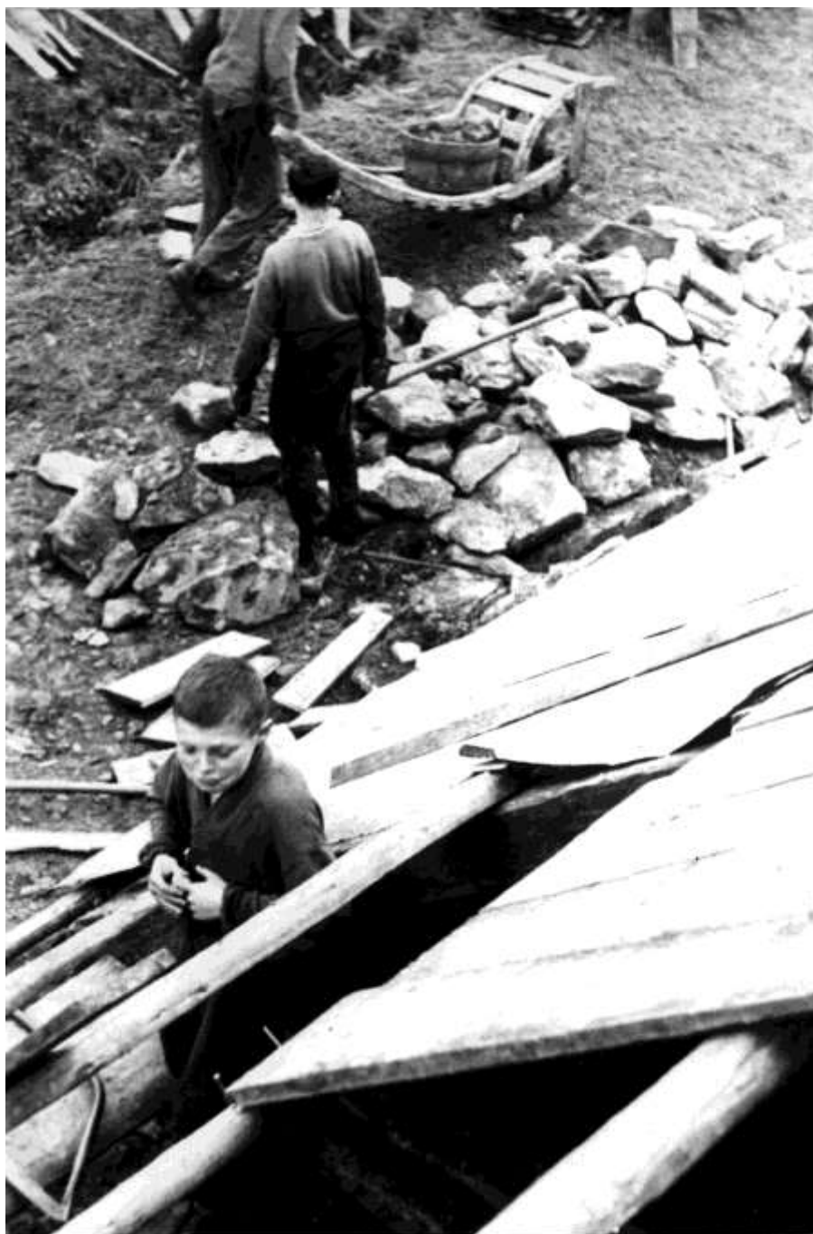
Adam ve střeše
